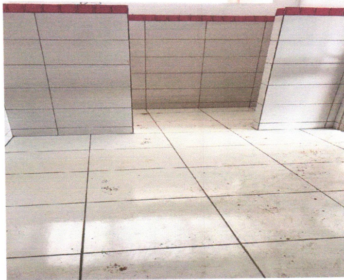
FOTO 150: ASSENTAMENTO PISO CERÂMICO
