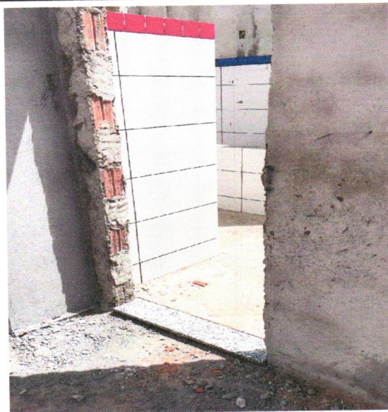
FOTO 140: SOLEIRA DE GRANITO
