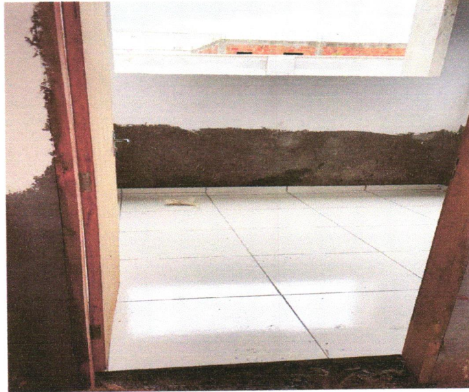
FOTO 149: ASSENTAMENTO PISO CERÂMICO
