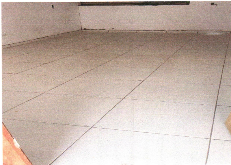
FOTO 151: ASSENTAMENTO PISO CERÂMICO E RODAPÉ
