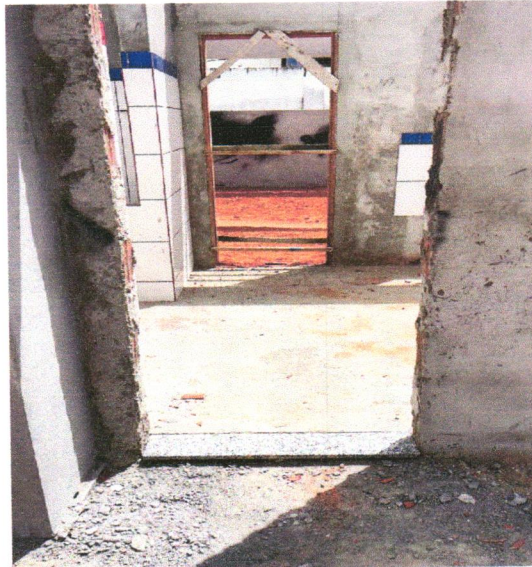
FOTO 139: SOLEIRA DE GRANITO
